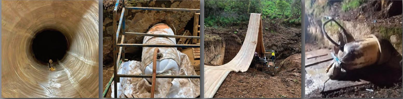
PROCESO DE REVESTIMIENTO TCPS: La instalación tenía una pendiente pronunciada, por lo que se utilizó curado con vapor.
