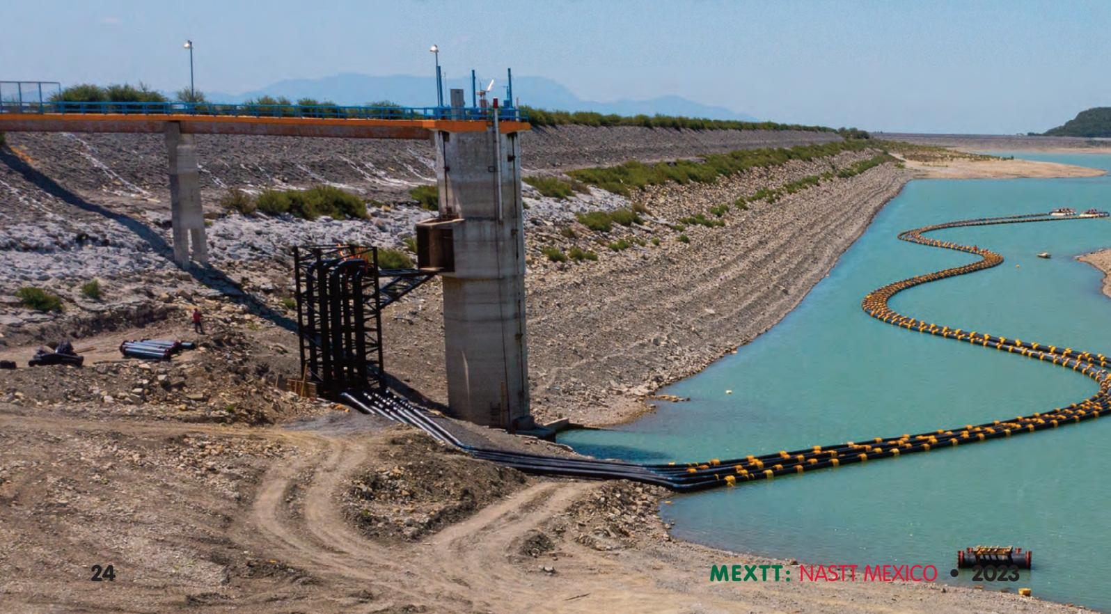
**Proyecto:** Tubería HDPE de 26" de Diam. RD21 – 360.00 ML Cruce Perforación Direccional Dirigida "HDD" Túnel 32" Diam. Conducción 26" Diam HDPE RD21
