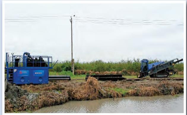
La selección del equipo HDD depende del tipo de subsuelo a perforar, diámetro y longitud de tubería a instalar. El uso de equipos HDD minimiza los costos operativos y el uso de maquinaria pesada.
