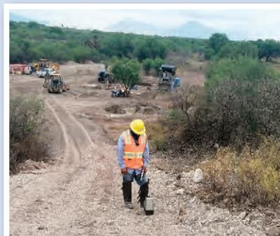
Avance del cabezal de perforación y su localización por medio de Sonda Electromagnética o GPS para guiado en el trazo diseñado.
