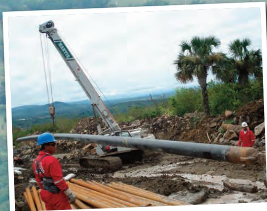
Se realizó una simulación del retroceso de la tubería para evaluar el daño potencial a la tubería de 16 pulgadas.
