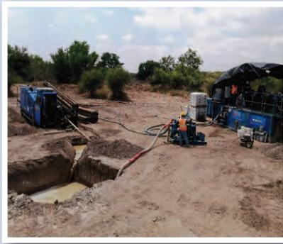
Preparación de formulación de lodos Bentoníticos – polímeros para la inyección en el proceso de perforación y limpieza.
