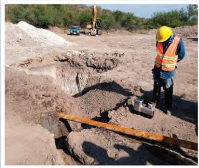
Verificación continua de profundidad por medio del radar de localización para el cumplimiento del perfil de perforación diseñado.
